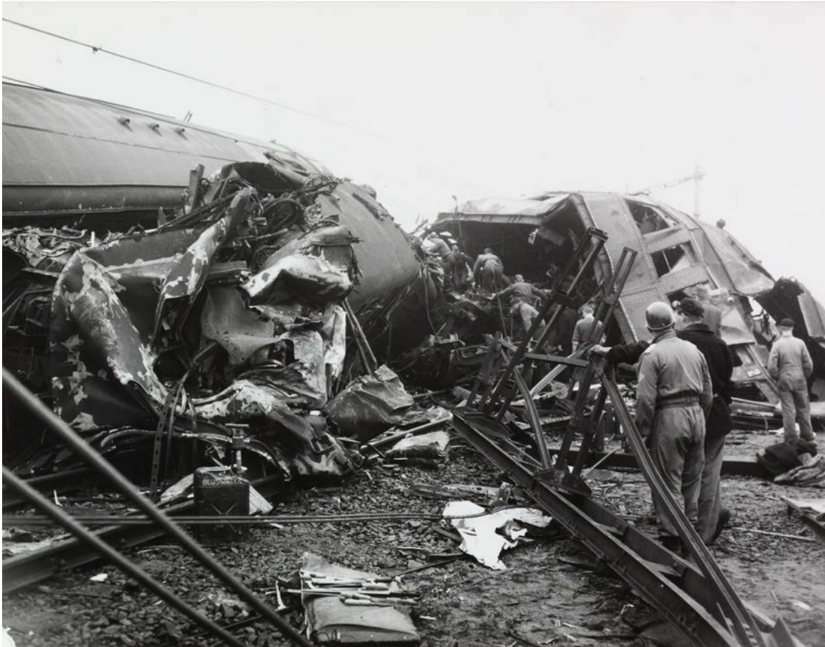
De Spoorwegongevallenraad heeft onder andere onderzoek gedaan naar de frontale botsing tussen twee reizigerstreinen op 08-01-1962 bij Harmelen. Bij dat ongeval kwamen 93 mensen om het leven. Het onderzoek heeft een belangrijke impuls gegeven aan de ontwikkeling en invoering van het Automatische Treinbeïnvloedingssysteem (ATB). Foto: Spoorwegmuseum, Utrecht.
