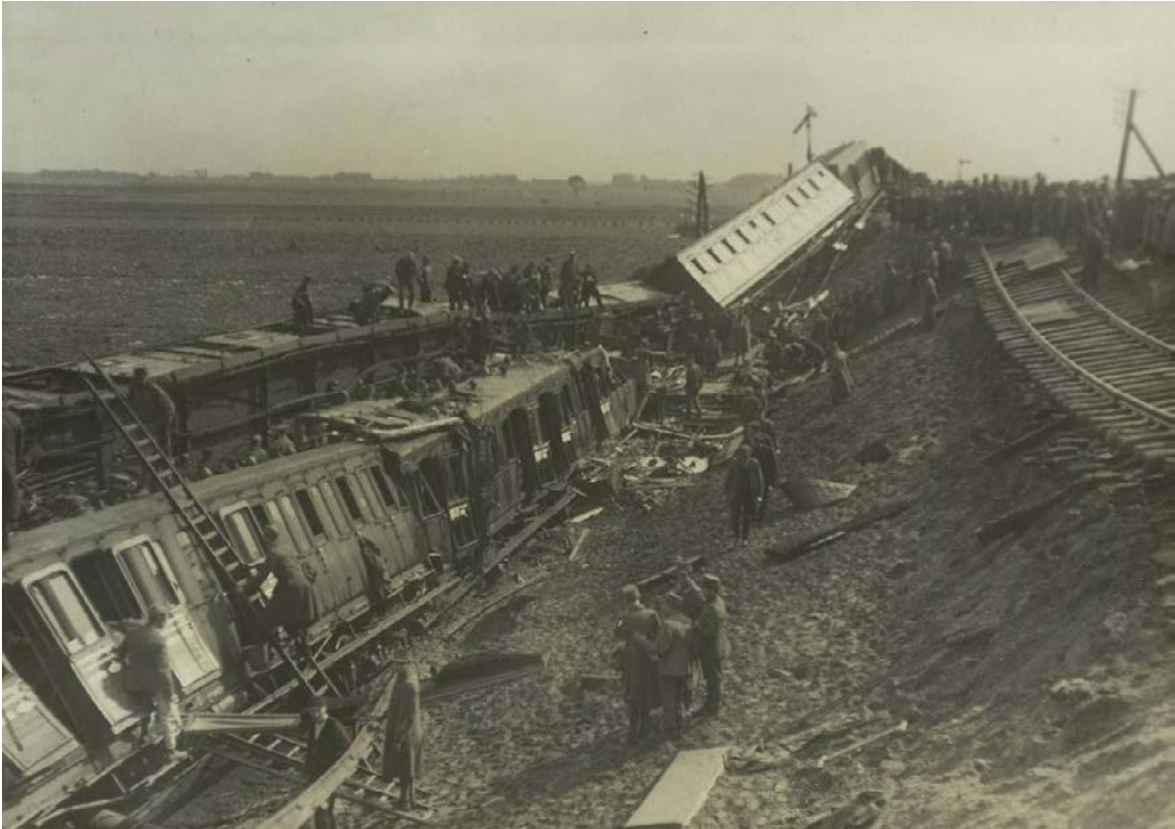
Het tweede onafhankelijk onderzochte treinongeval betrof de ontsporing van een reizigerstrein in 1918 bij de spoorbrug in Weesp. De ontsporing, waarbij 41 mensen om het leven kwamen, gebeurde doordat de spoordijk als gevolg van een te hoog grondwaterpeil over een lengte van honderd meter verzakte. Foto: www.fotos.serc.nl/noord-holland/weesp/weesp-53875
